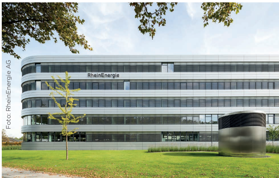
Die RheinEnergie setzt auf Nachhaltigkeit: Das neue Verwaltungsgebäude verbraucht so gut wie keine Energie, auch in der Kommunikationstechnik achtet das Unternehmen auf „Green IT“.
